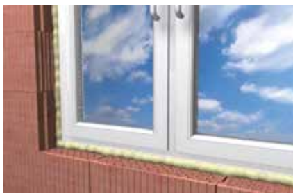
Giunti di connessione in serramenti
