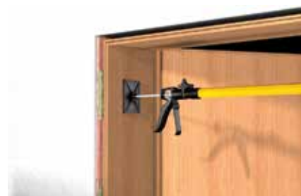
Schiumatura di telai di porte
